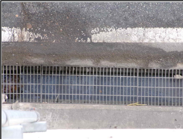
지하차도 저점부 배수로 상태양호
