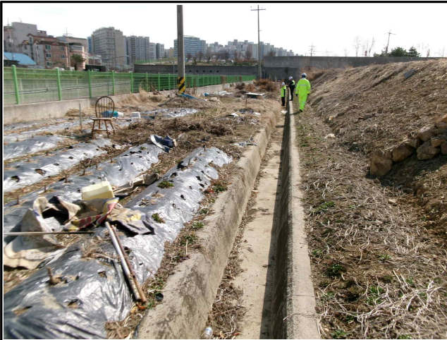
지하차도 상부 배수로 점검
