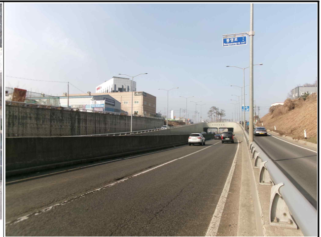
지하차도 입출구부 상태양호
